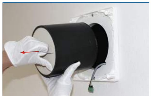
Herausziehen des Keramikwärmespeichers
