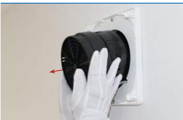
Herausziehen von inVENTron®: Leitwerke und Reversierventilator
