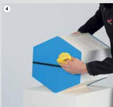
4 Abdeckung des Zehnder Enthalpietauschers abtrocknen und ihn eine Stunde lang gut abtropfen lassen.
